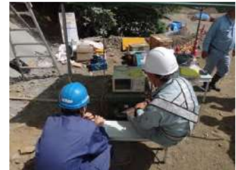
緊張～測定状況
