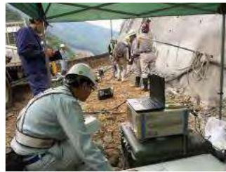
計測状況の例
