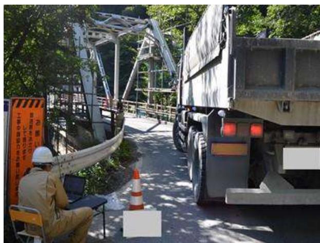
図 1.3-4 計測状況の例
