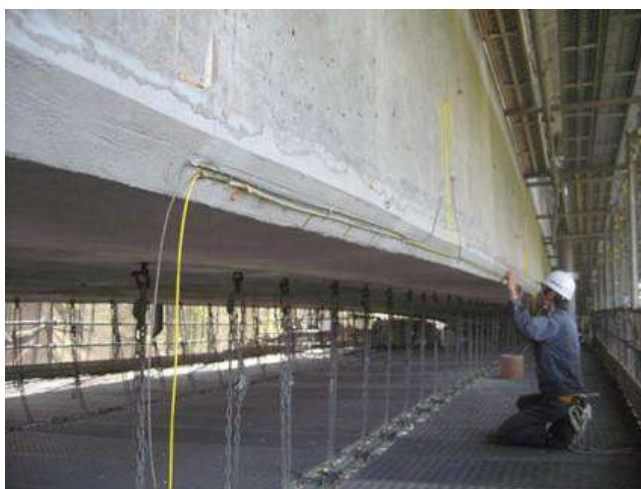
図 1.3-3 光ファイバセンサ設置の例
